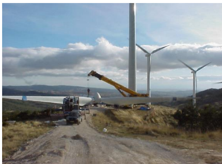
Figura 3-3: Ingombro del rotore a terra
