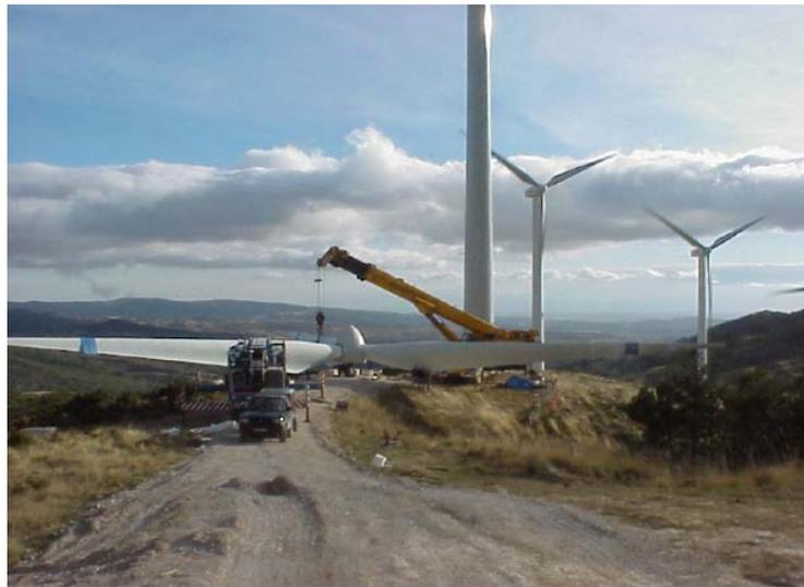
**Figura 4-4: Ingombro del rotore a terra**
