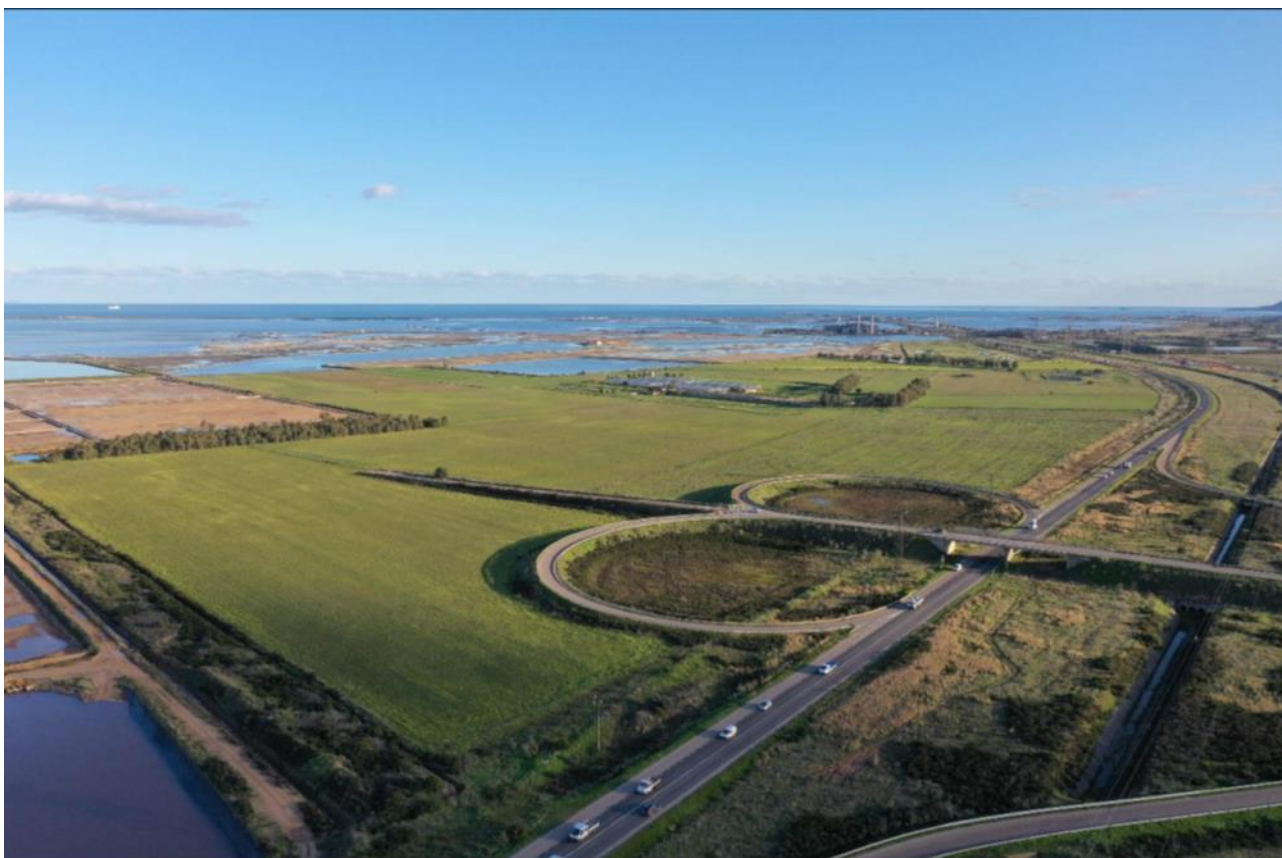
Vista generale dell'area di impianto
