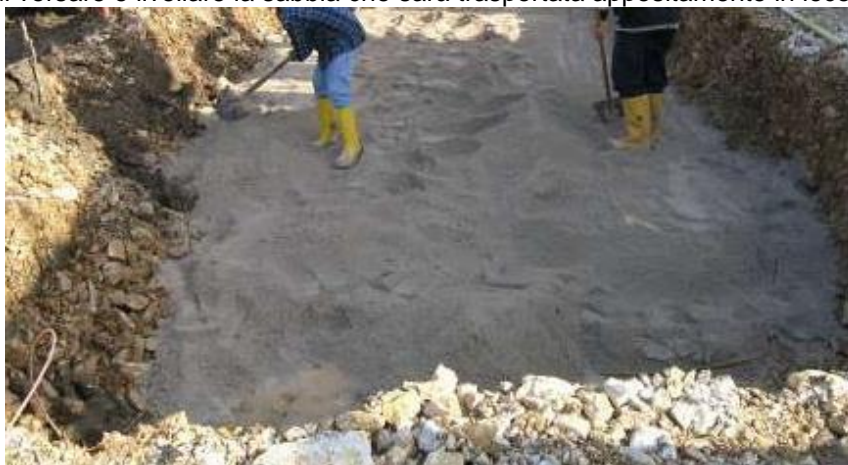
FIGURA 16 - SBANCAMENTO PIANO POSA CABINE
