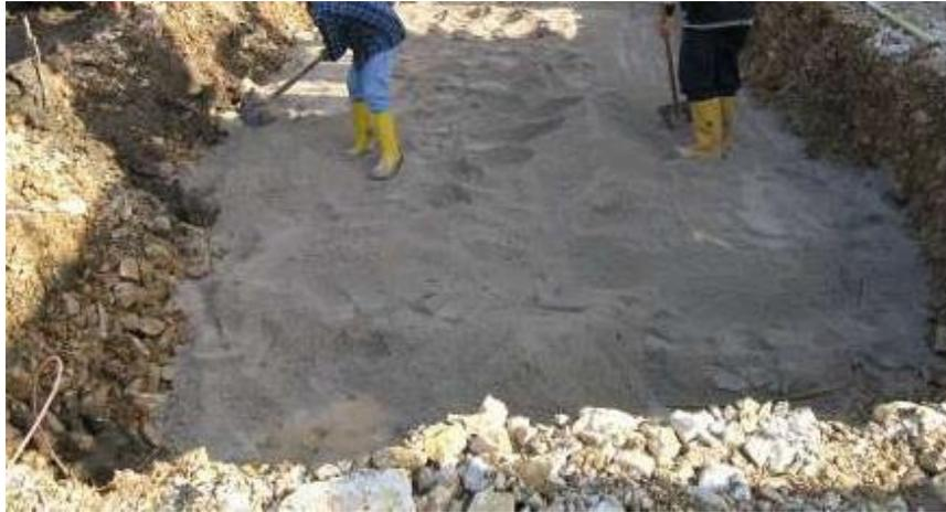
**FIGURA 6 - SBANCAMENTO PIANO POSA CABINE**
