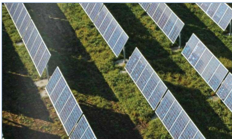
Fig. 6: esempio di tracker ad asse variabile (da stralcio progettuale)
