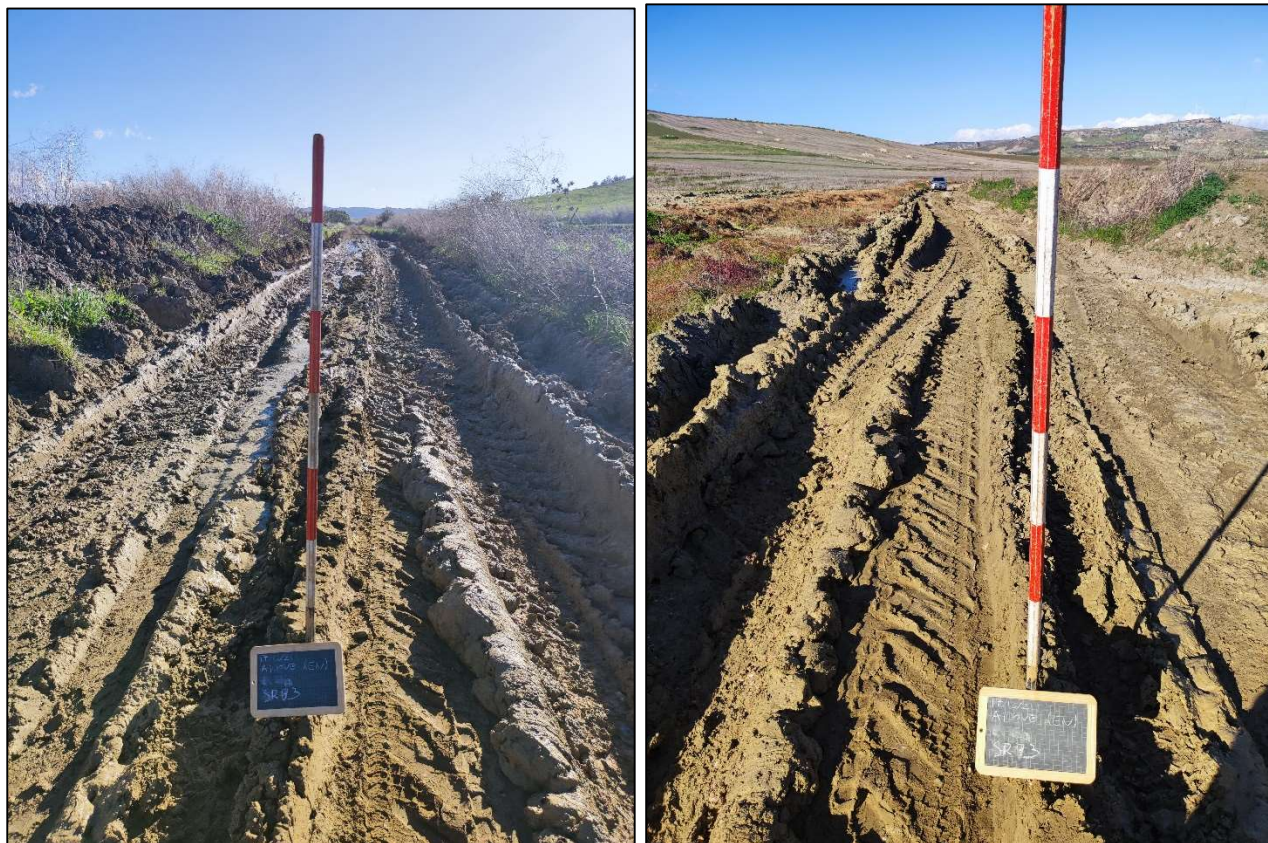
Fig. 18: la strada di accesso ad L5-6 (SP 73)
