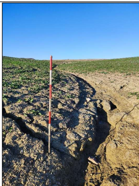
Solchi da ruscellamento
