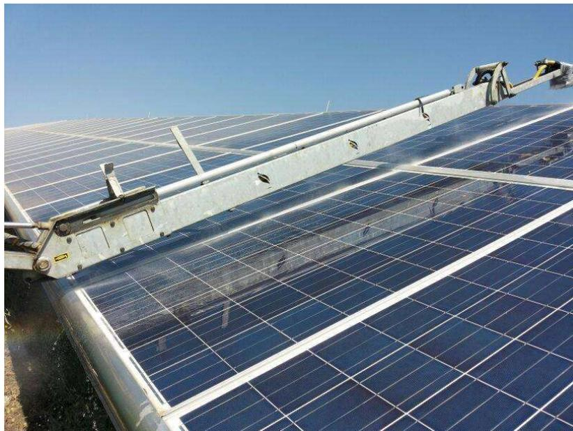
*Figura 53 - Operazioni di pulizia moduli effettuate con sistema atomizzatore con uso esclusivo di acqua.*
