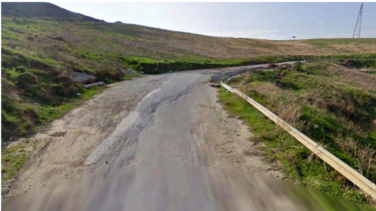
Fig. 5.1.3: Area in dissesto lungo la SP8 interessata dal percorso del cavidotto.
