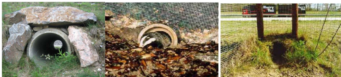
Figura 21 -Esempi di tipologie di sottopassi per la fauna che verranno realizzati
