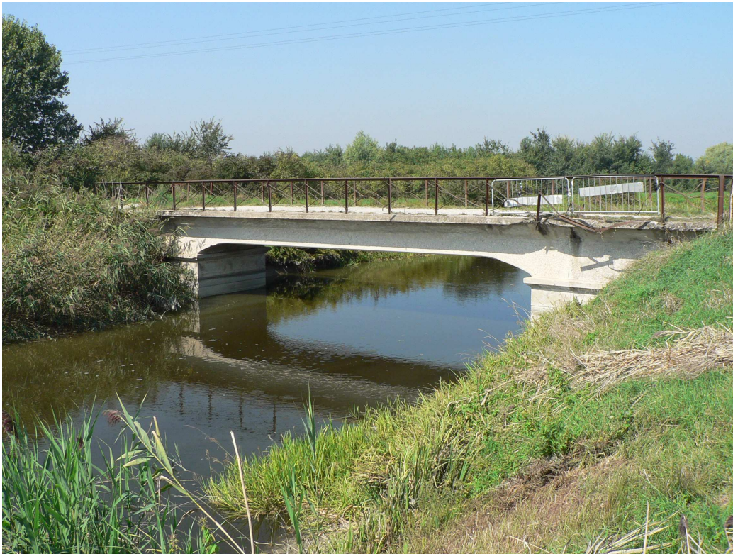
FIGURA 2.1-3 FOSSA RASO PONTICELLO SULLA STRADA COMUNALE A VALLE DELL'ATTRAVERSAMENTO
