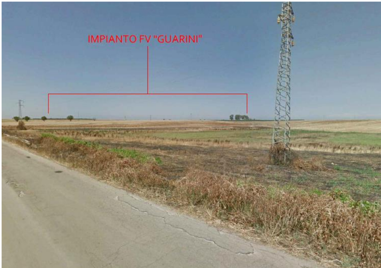
Figura 8: Vista prospettica dell'impianto da Masseria Vaccaro
