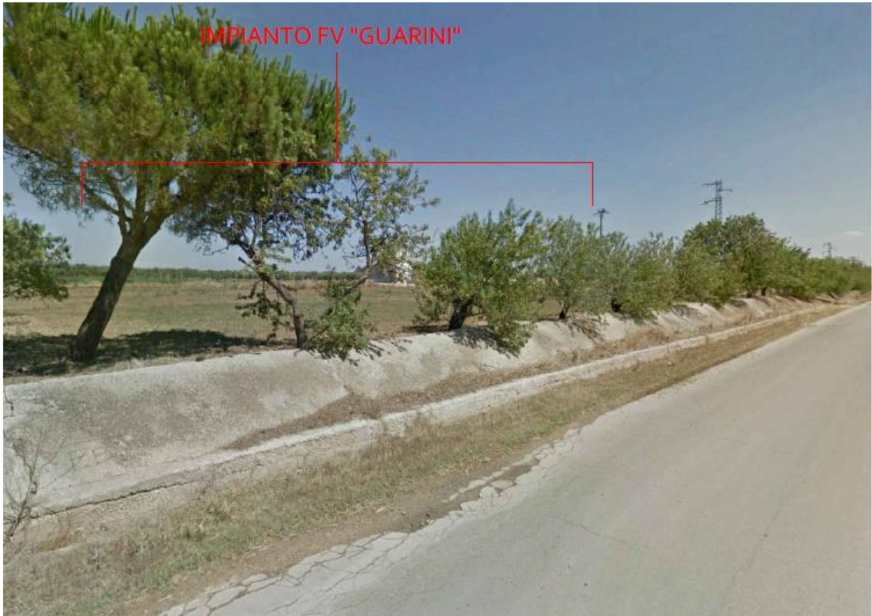
Figura 5: Vista prospettica dell'impianto da Masseria Cuggiò.
