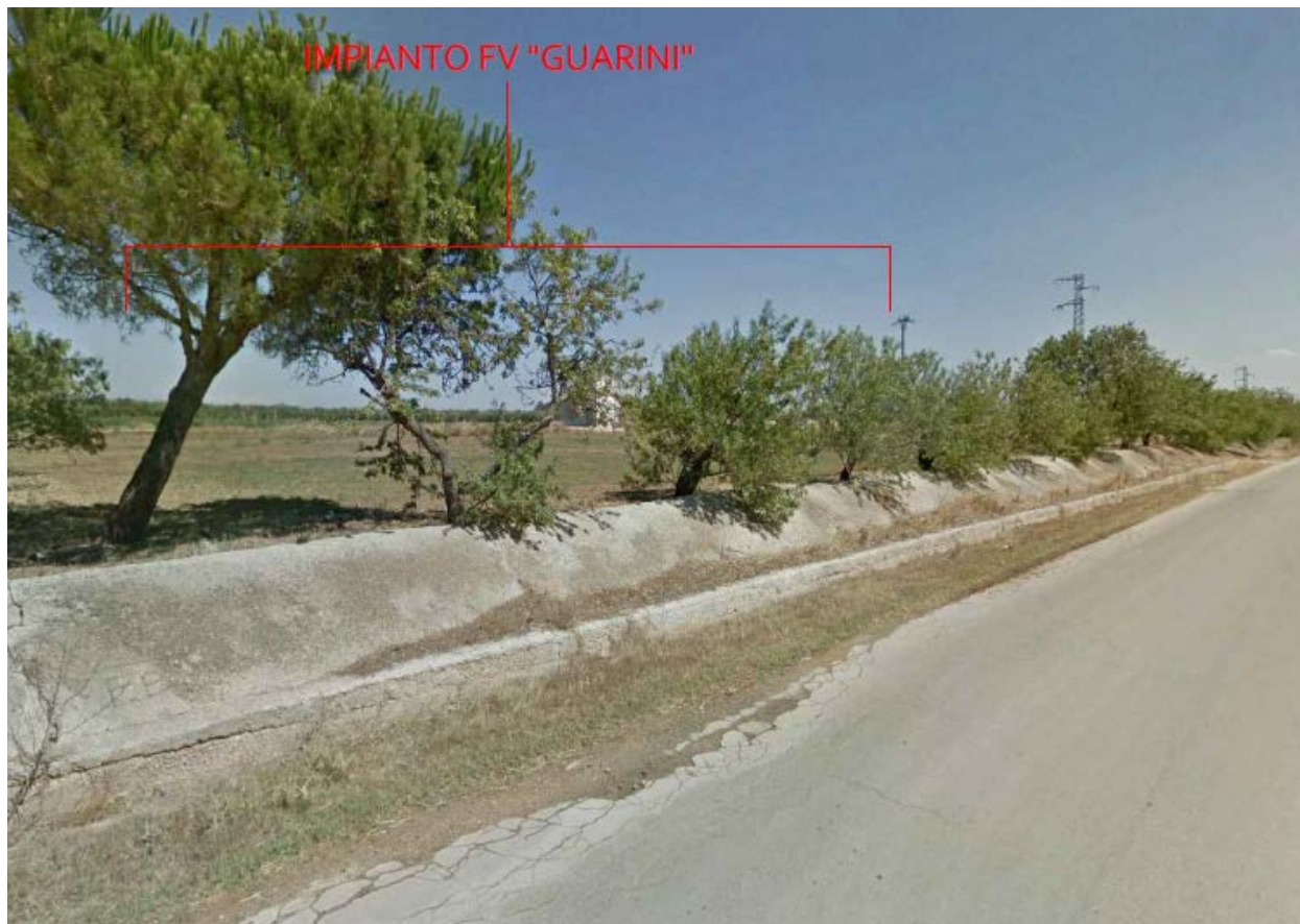
Figura 8: Vista prospettica dell'impianto da Masseria Cuggiò.
