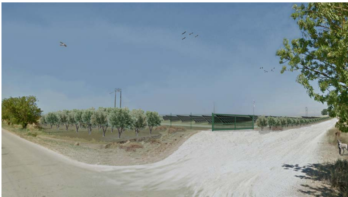
Figura 37: Vista dal punto 3 posto sulla S.P. 44 "Acquaro" – con simulazione di schermatura alberata di mitigazione post operam.
