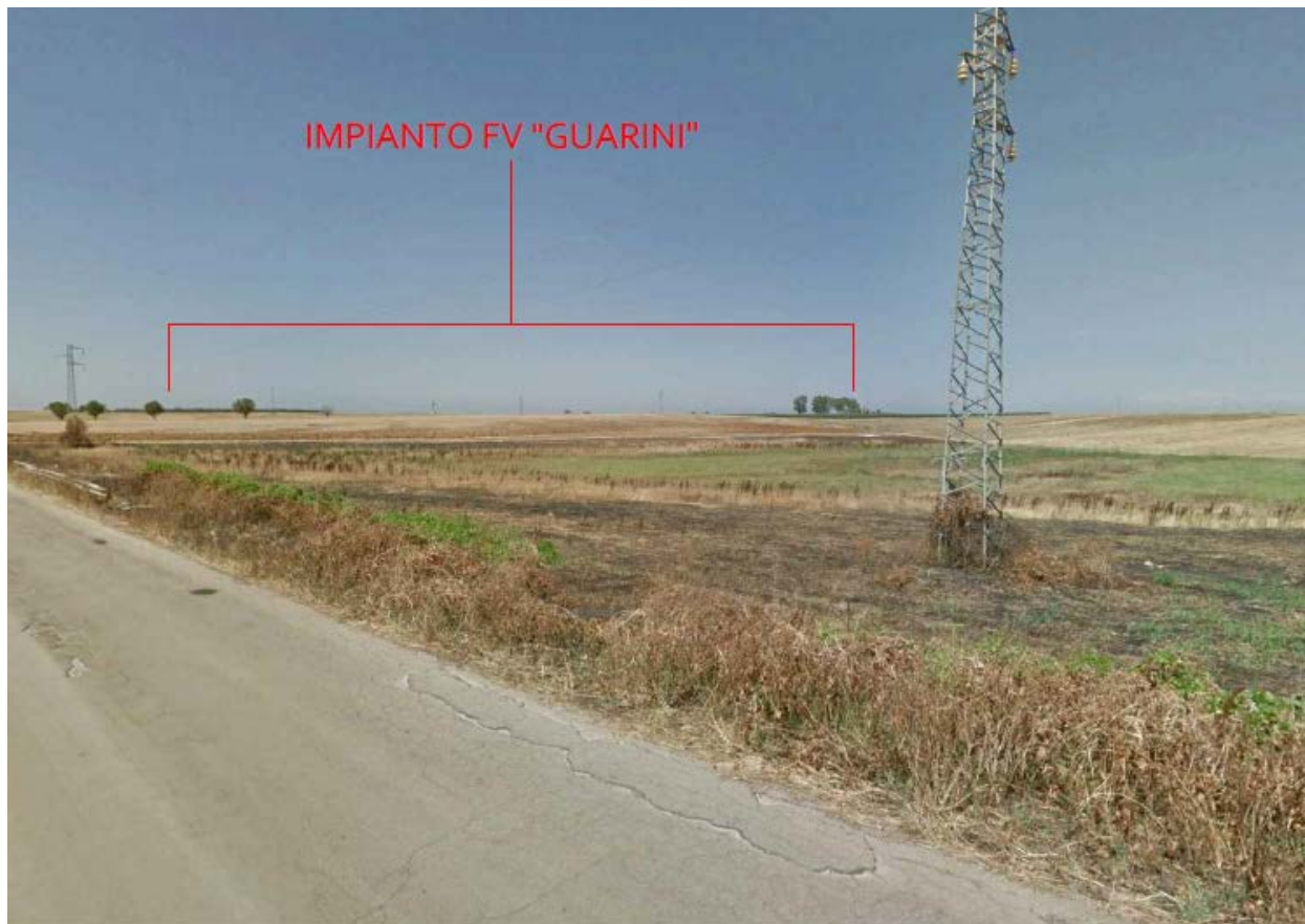
Figura 12: Vista prospettica dell'impianto da Masseria Vaccaro
