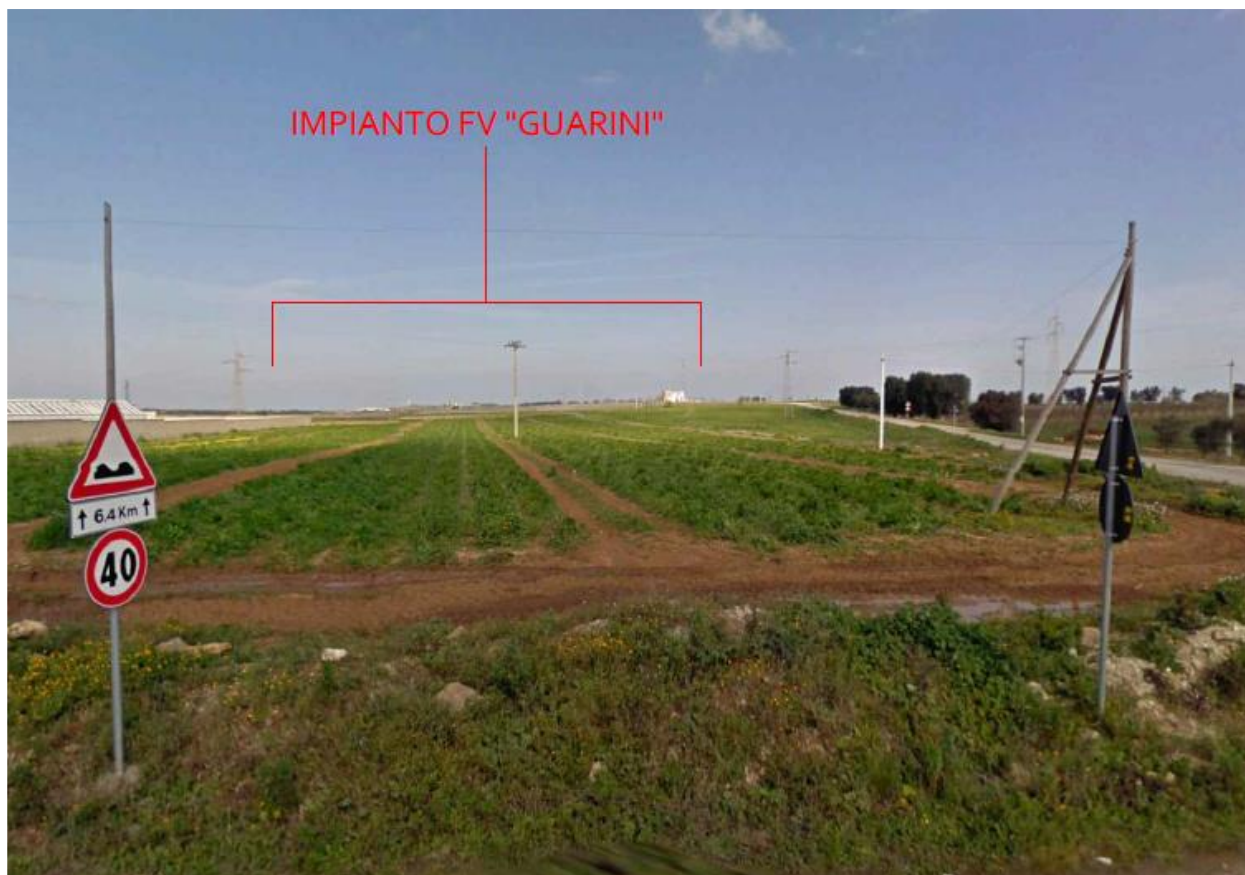
Figura 43: Vista prospettica dell'impianto da Masseria Baroni
