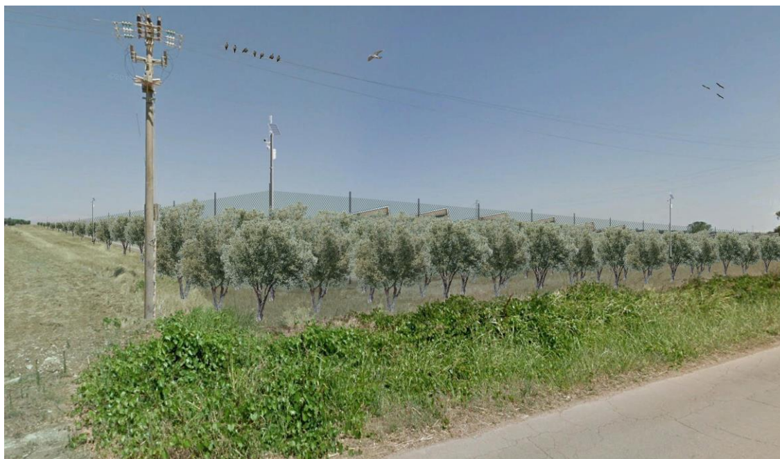
Figura 70: Vista dal punto 1 posto sulla S.P. 44 "Acquaro" – con simulazione di schermatura alberata di mitigazione post operam.
