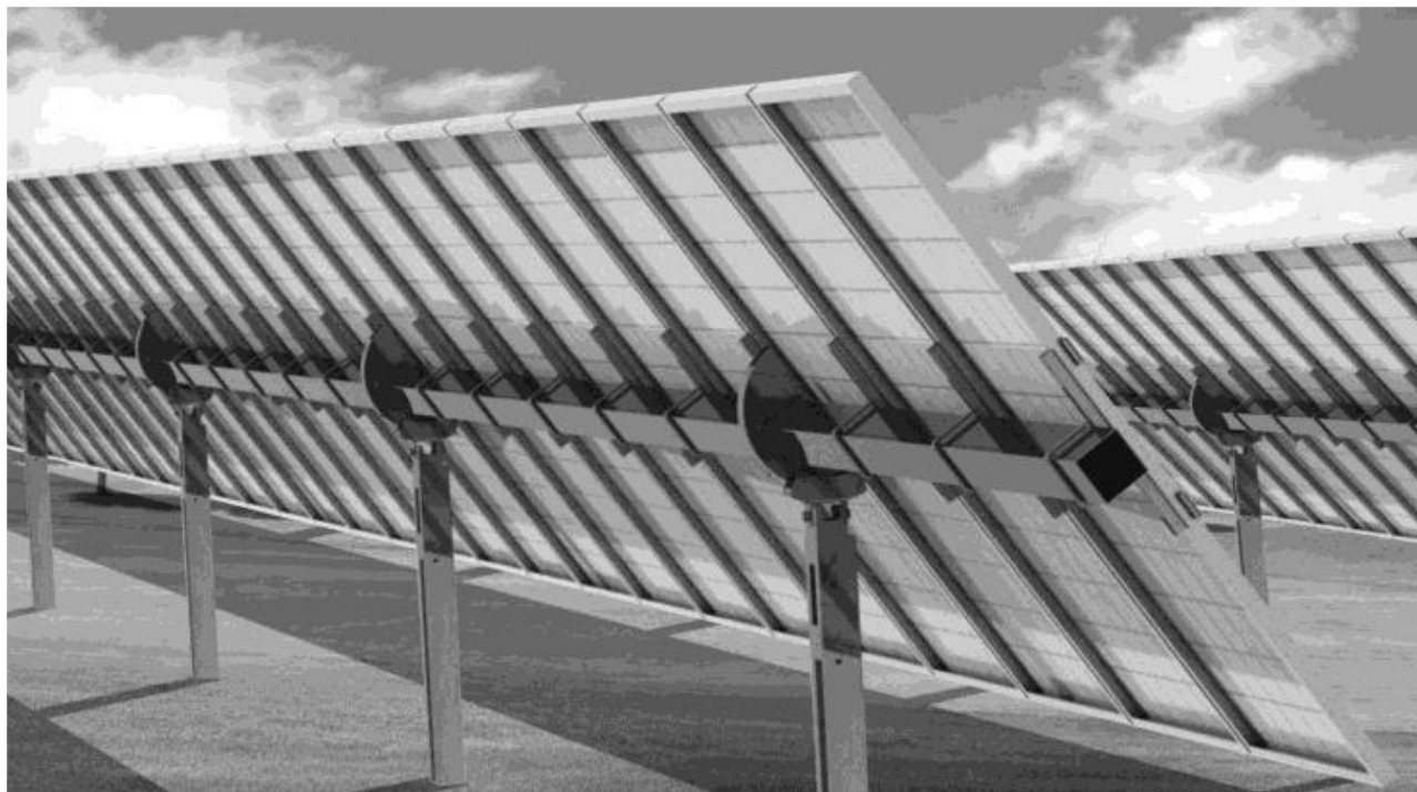
Fig. 1.3 – Tracker o inseguitore monoassiale
