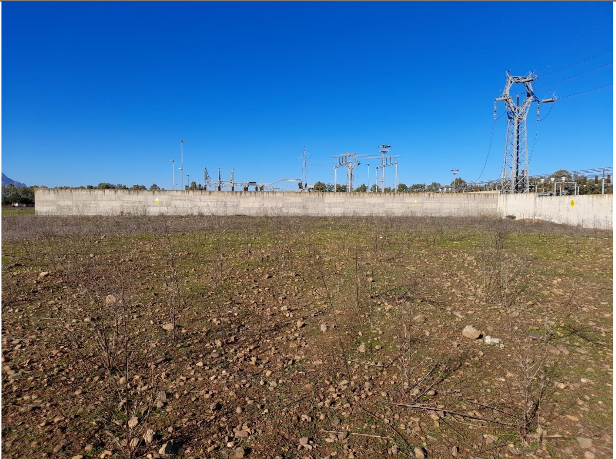
Fig. 45 – Area della Sottostazione Elettrica Utente (UR 6) da SE verso NO
