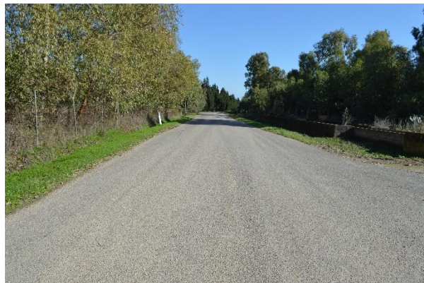
Figura 26 – Strada asfaltata interessata dalla posa del cavidotto MT
