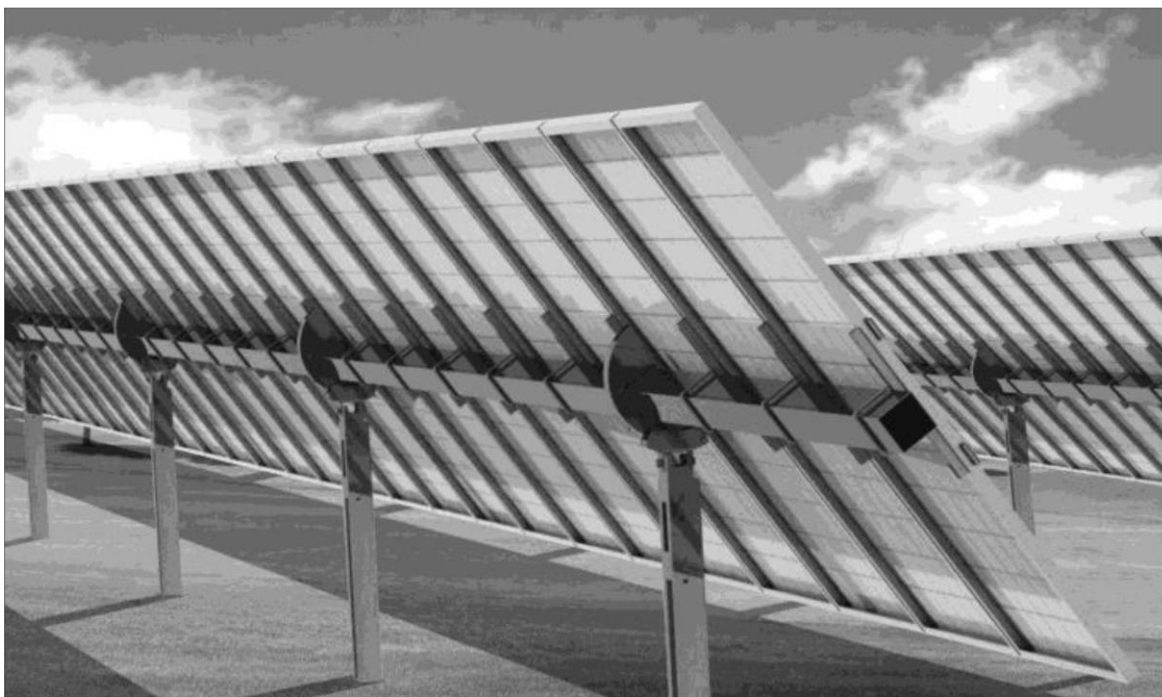
Figura 6: tracker: inseguitore monoassiale.
