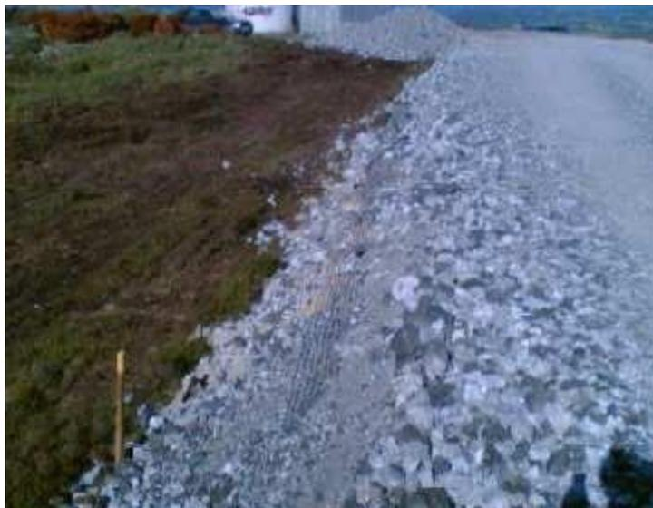
Figura 16: Superficie stradale in misto stabilizzato e drenaggio.
