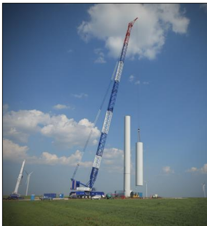
Figura 42 Sollevamento, posizionamento e fissaggio dei tronconi intermedi
