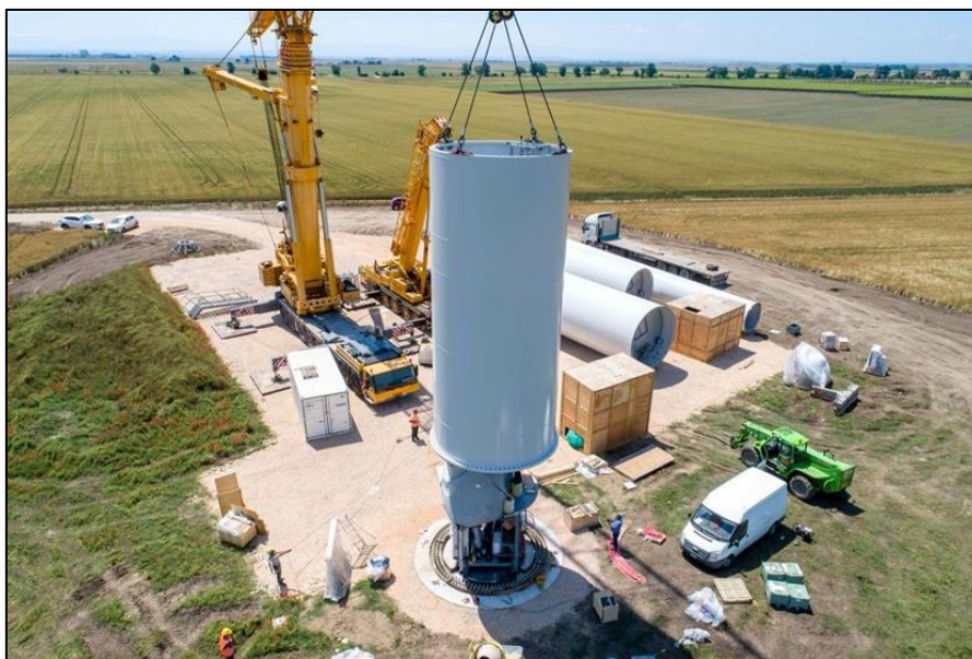
Figura 41 Sollevamento e posizionamento alla fondazione della parte inferiore della torre
