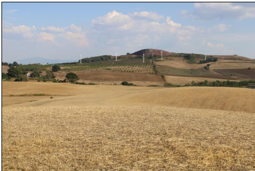
Figura 29 Area di sedime piazzola aerogeneratore VT7
