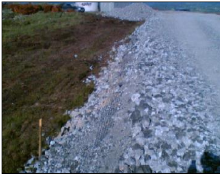
Figura 38 Superficie stradale in misto stabilizzato e drenaggio
