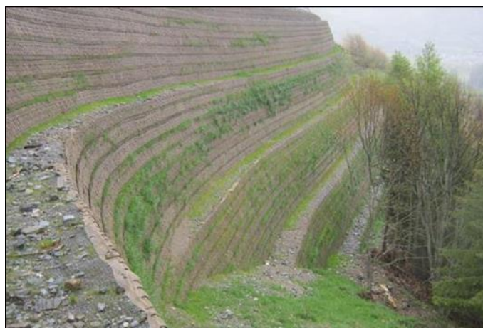
Figura 11 Esempio di terre rinforzate
