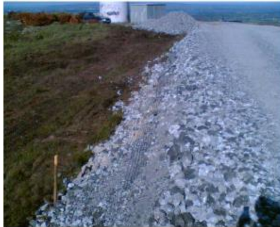
Figura 14 - Tipologia di nuova viabilità in misto stabilizzato
