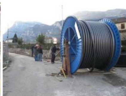
POSA DEI CAVI
