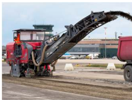
SCARIFICAZIONE ASFALTO
