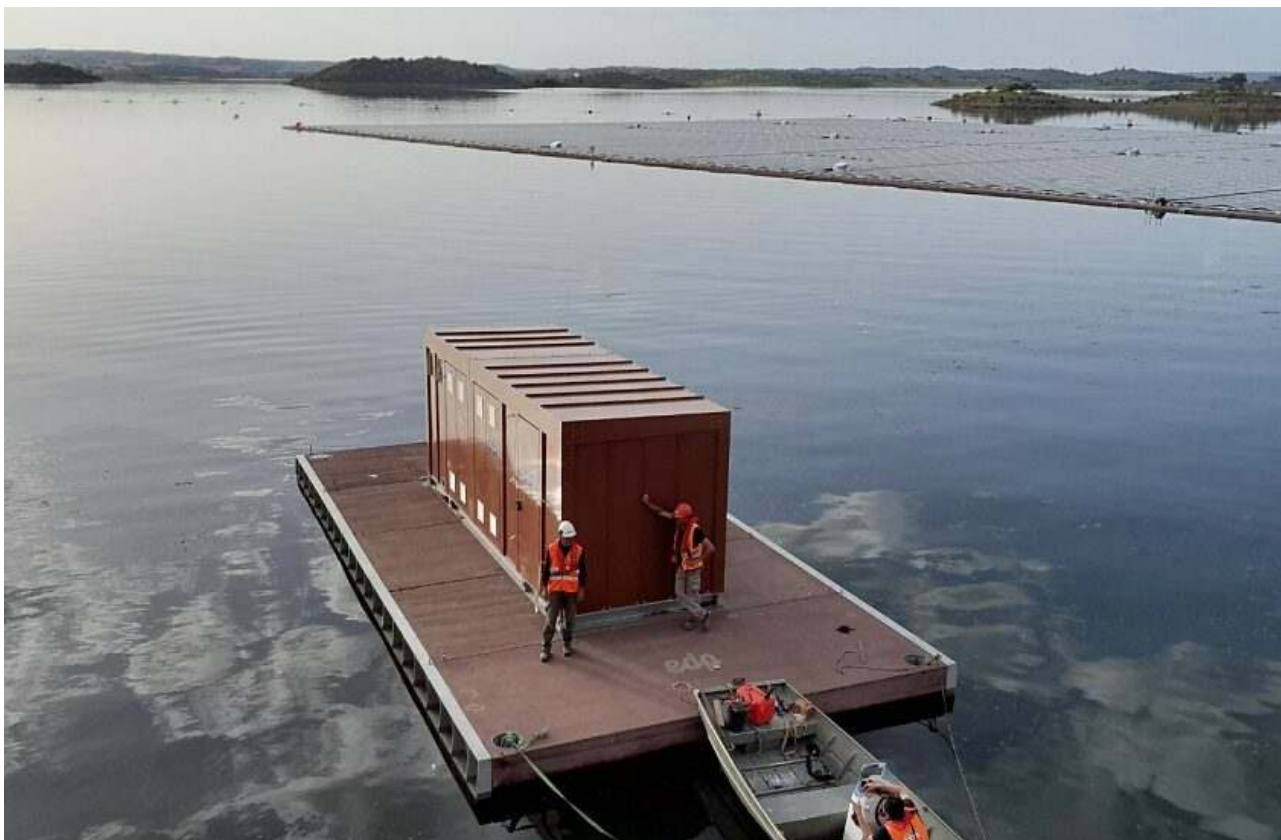
Figura 5.2 – Esempio di modulo di trasformazione compatto per parchi fotovoltaici offshore.
