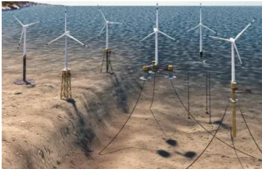
Figura 37 – schema delle tipologie di fondazioni galleggianti - Fonte: USA Energy e Flickr.com
