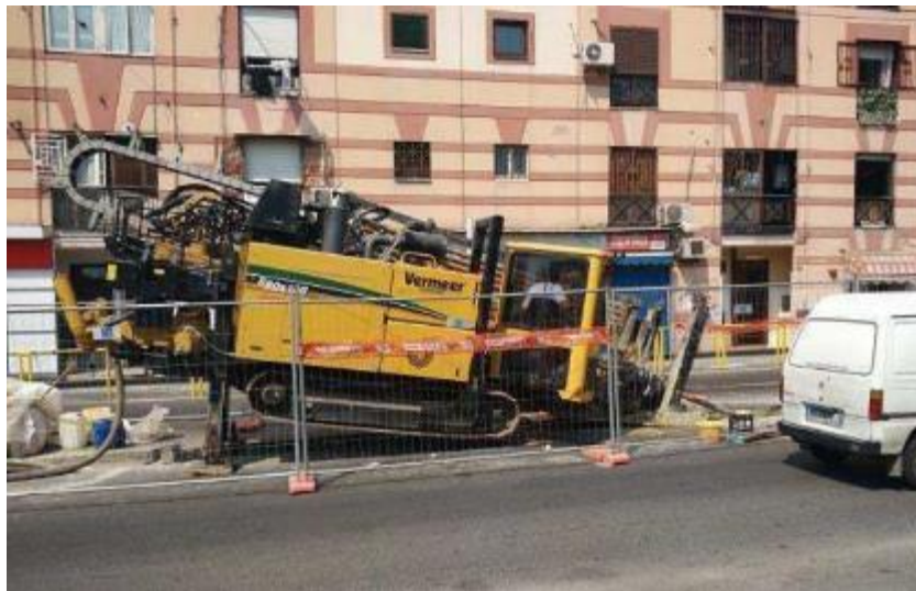
Figura 4: Macchina operatrice per esecuzione TOC
