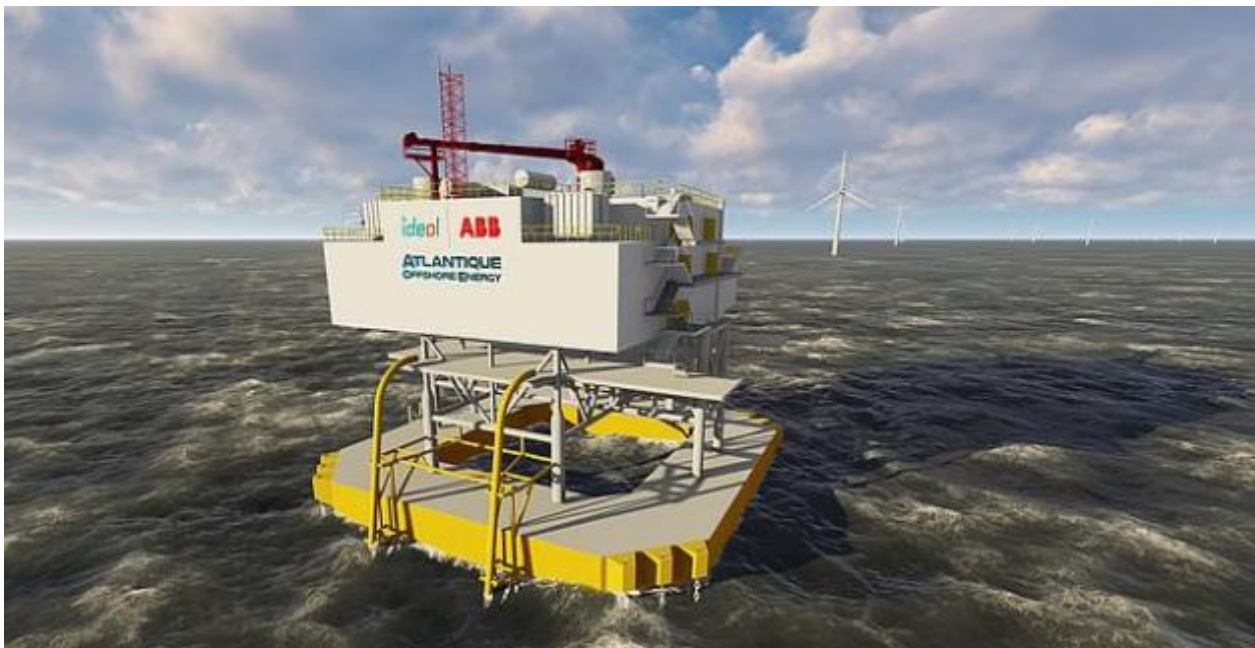
Figura 18 – Esempio di Stazione elettrica galleggiante – Fonte: ideol
