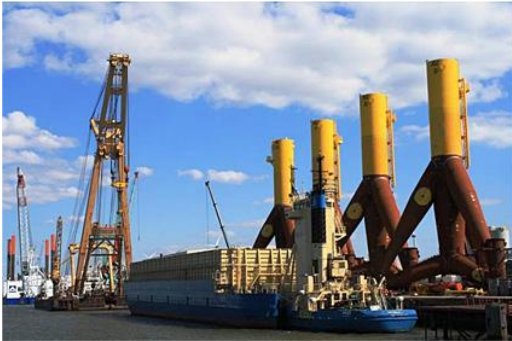
Figura 29 – Stoccaggio delle strutture di fondazioni in porto
