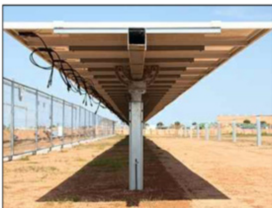
Figura 1 -Rappresentazione fotografica di un insegitore monoassiale
