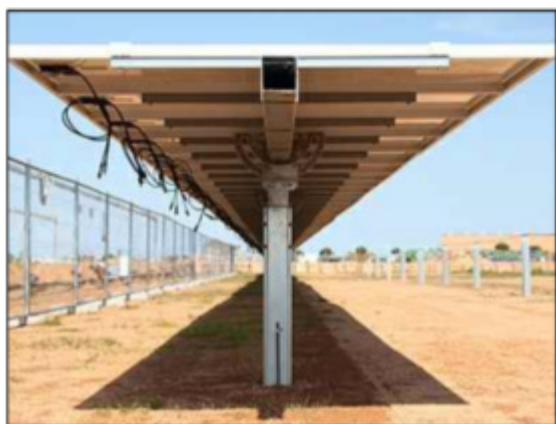
Figura 1 -Rappresentazione fotografica di un inseguitore monoassiale
