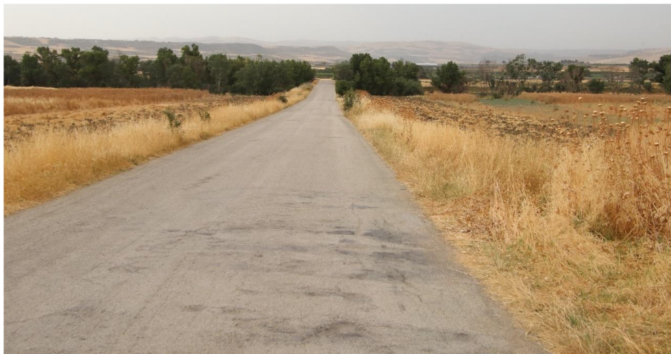
Figura 52 Gran parte del progetto si sviluppa su strada asfaltata in contesto agricolo (soprattutto cerealicolo); la porzione di territorio di maggiore interesse naturalistico riguarda il corso del Fiume Ofanto con la sua vegetazione riparia (fascia alberata nella foto) – Fonte: Relazione sulla Valutazione d'incidenza
