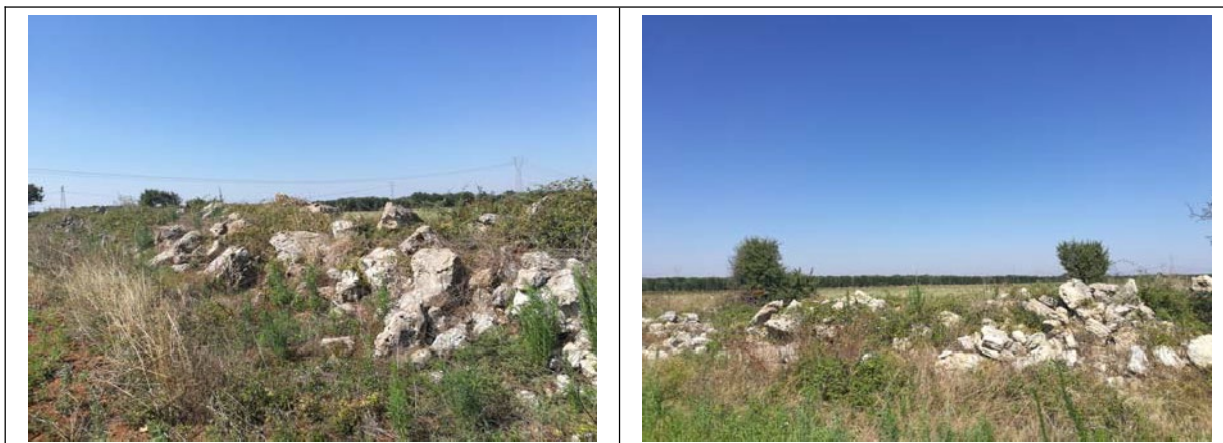
Muretto a secco nel Campo A
