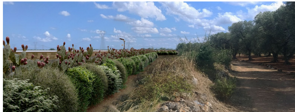
Fotoinserimento - Vista area di impianto post operam
