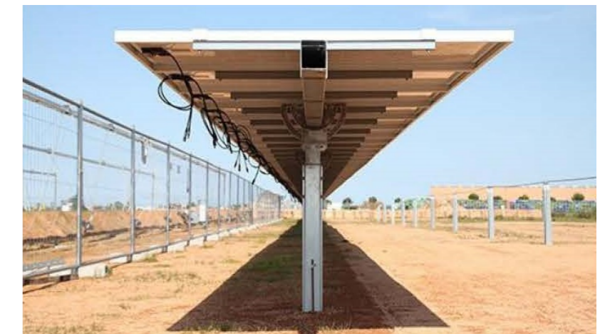
Inseguitore fotovoltaico mono assiale
