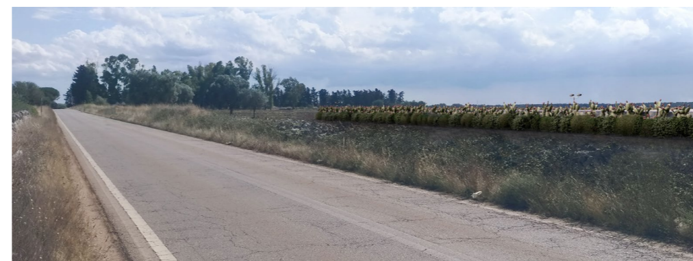
Fotoinserimento - Vista area di impianto post operam
