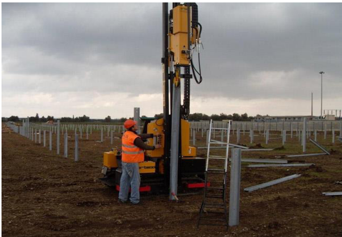
Figura 1 - Rimozione palo con macchina operatrice
