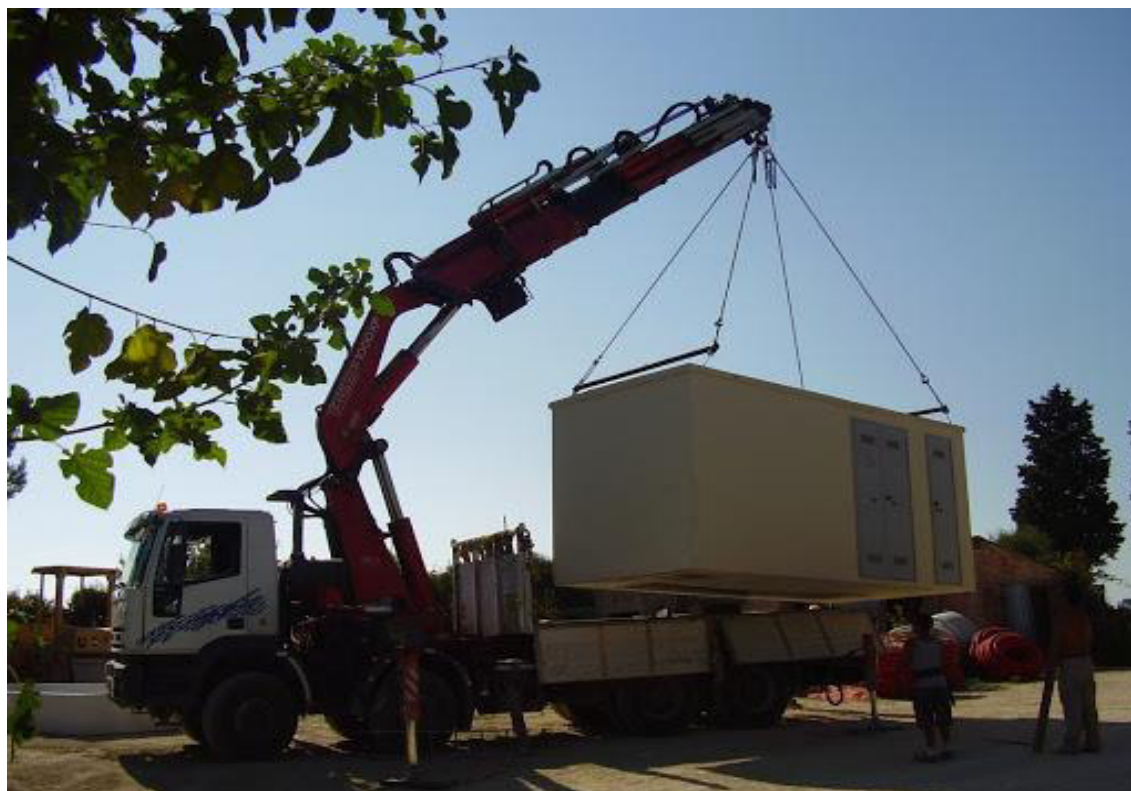
Figura 2 - Smontaggio e rimozione cabine di campo
