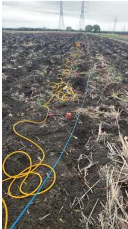
FOTO 5: postazione di energizzazione SS3
