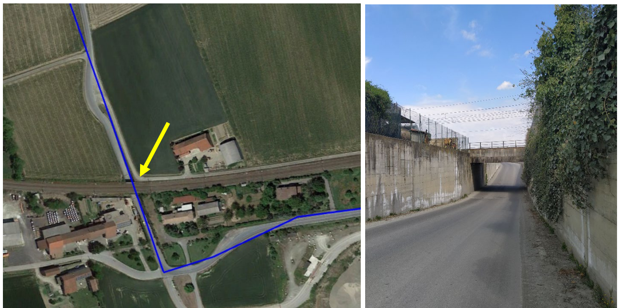
Figura 111 – Dettaglio dell’incrocio tra la linea ferroviaria cavalcavia e il tracciato del cavidotto. A destra immagine del cavalcavia
