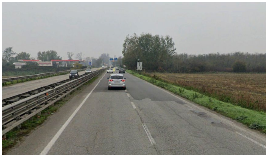
Figura 112 – Dettaglio dell’incrocio tra la linea ferroviaria cavalcavia e il tracciato del cavidotto. A destra immagine del cavalcavia
