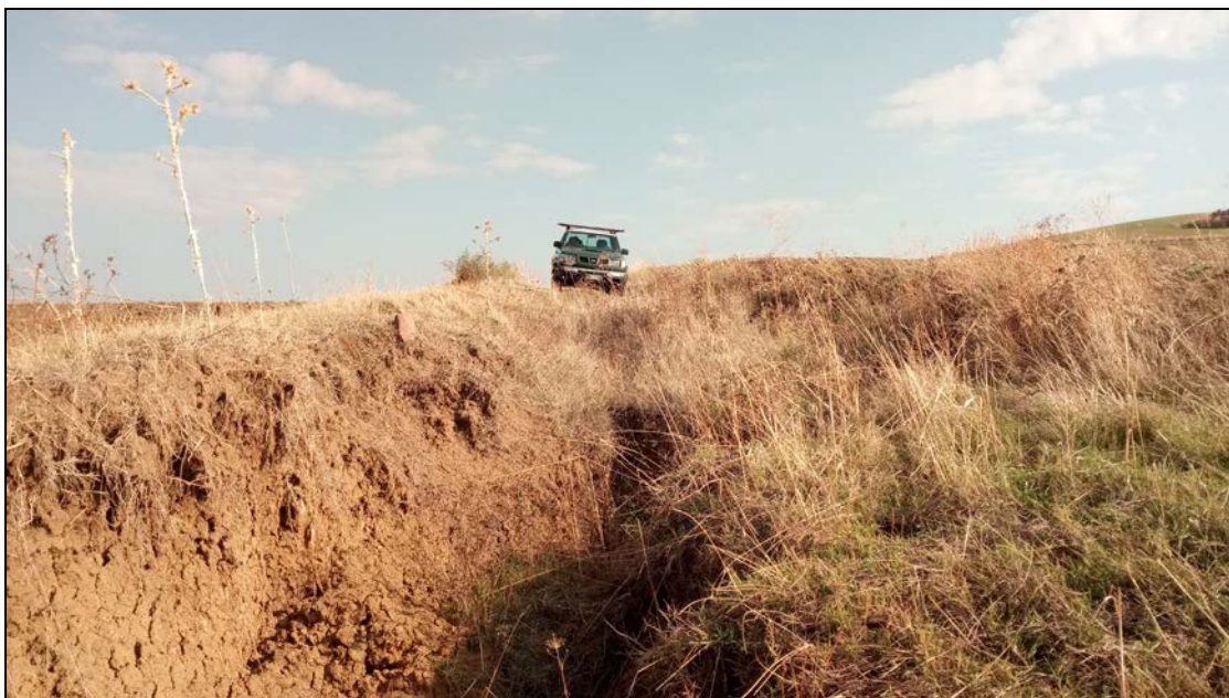
Fig. 17: Solco provocato dal ruscellamento concentrato nelle argille lungo una pista agricola.
