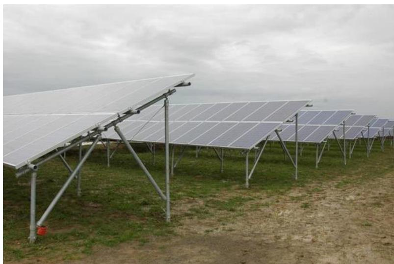
**Figura 18:** Esempio impianto a strutture fisse
