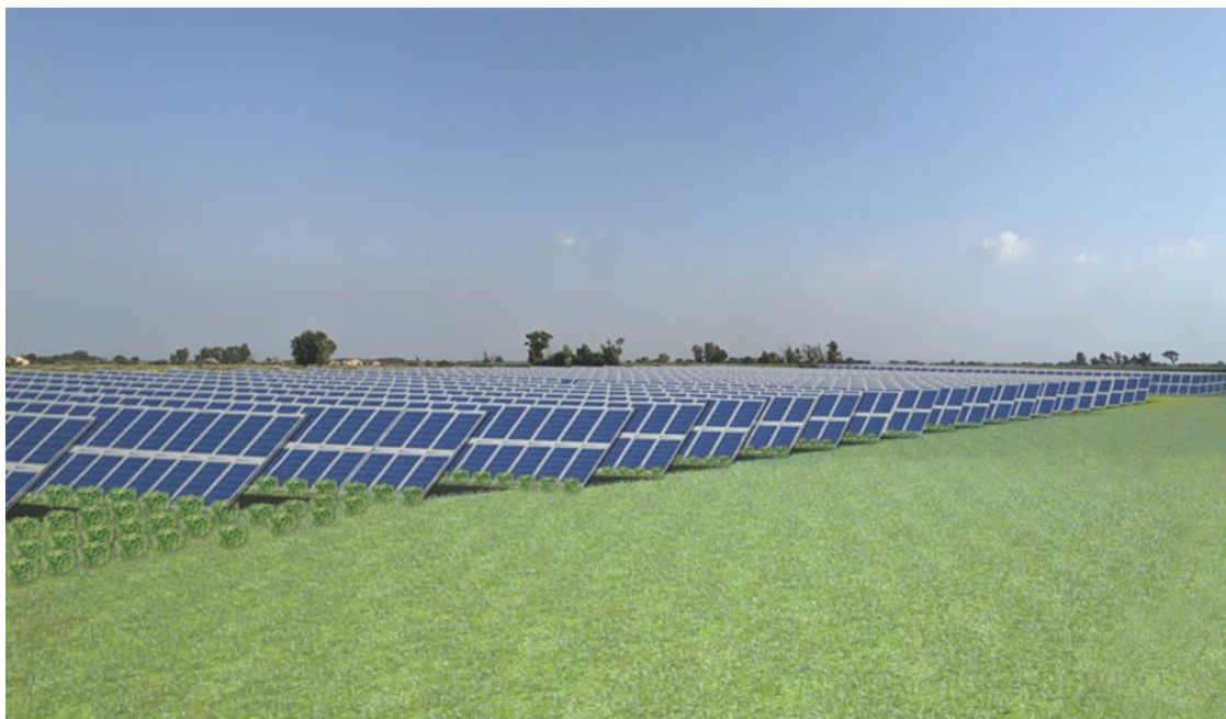
Figura 44: Particolare tipo simulazione impianto mediante fotomodellazione con colture tra i filari
