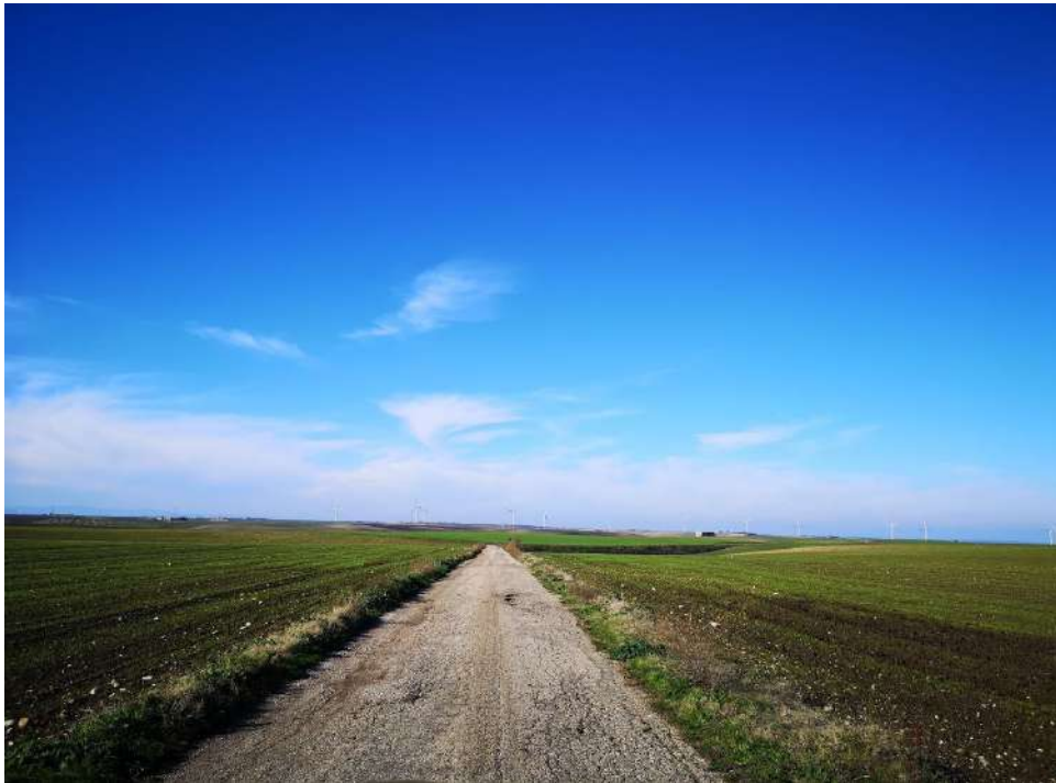
Foto 8. Cavidotto. S.P. 127 di Ariaccia. Vista da SE.
