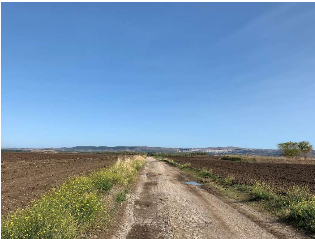
Foto 7. Cavidotto. Strada secondaria. Vista da W.
