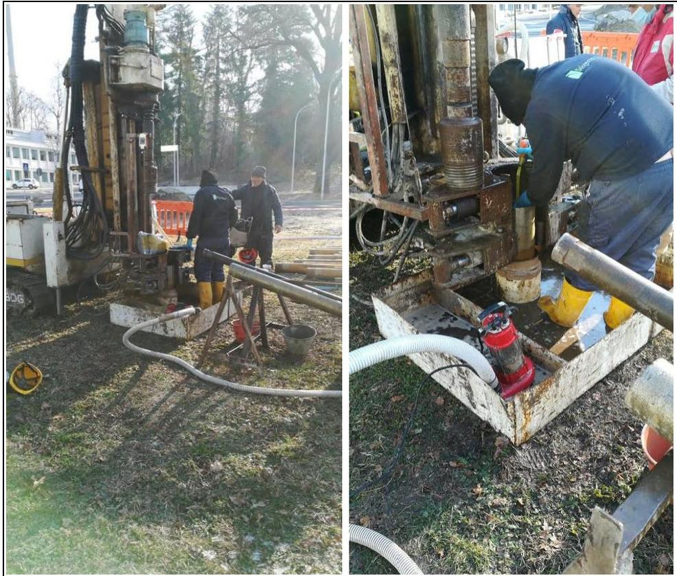
Figura 7-1 – Accorgimenti per il contenimento e recupero dell’acqua nelle operazioni di perforazione
