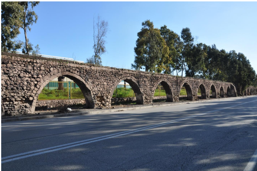
Figura 12: strada provinciale Statte - Taranto, veduta Est dell'Acquedotto del Triglio
