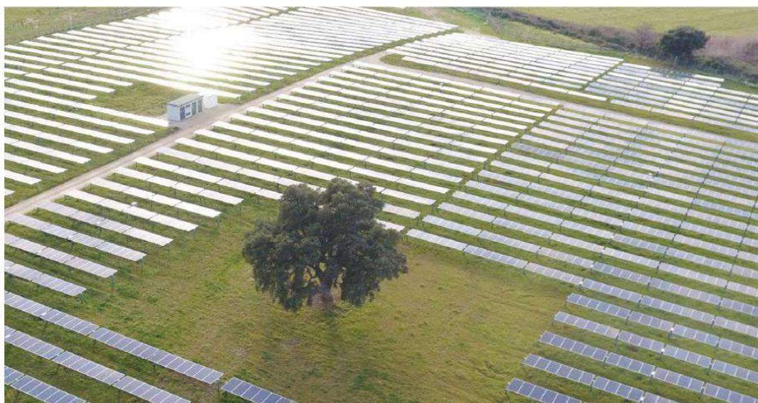
Figura 3 - esempio di impianto realizzato con i tracker proposti e pannelli in configurazione monofilare
