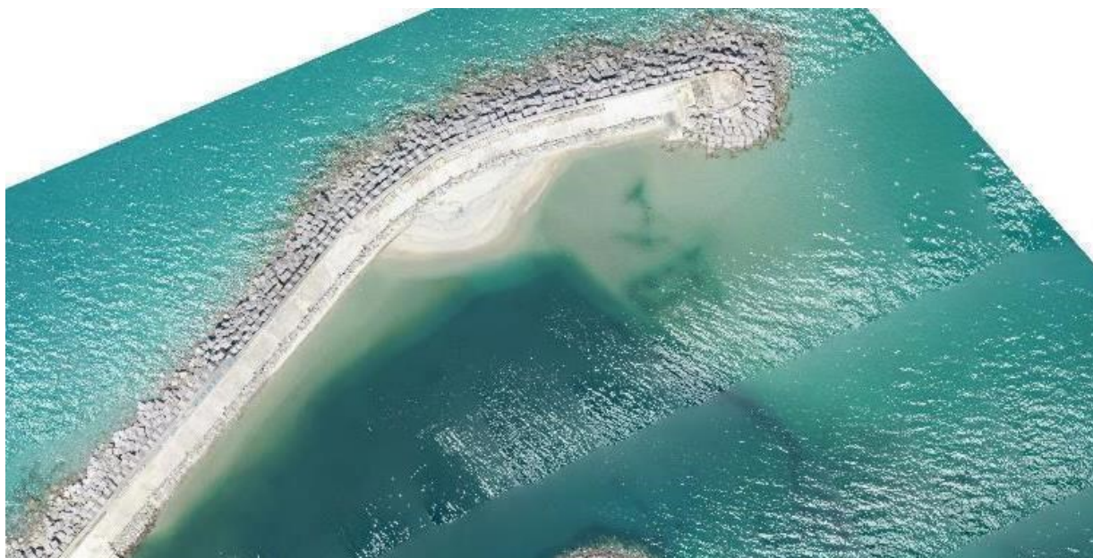
Figura 7: Accumuli di sabbia in corrispondenza dell'imboccatura – Ortofoto marzo 2020.
