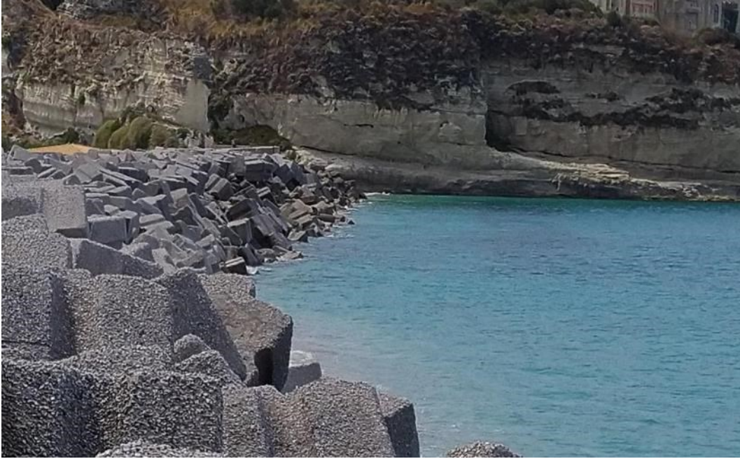
Figura 4: Vista della mantellata nel tratto ad elevata ripidità.
