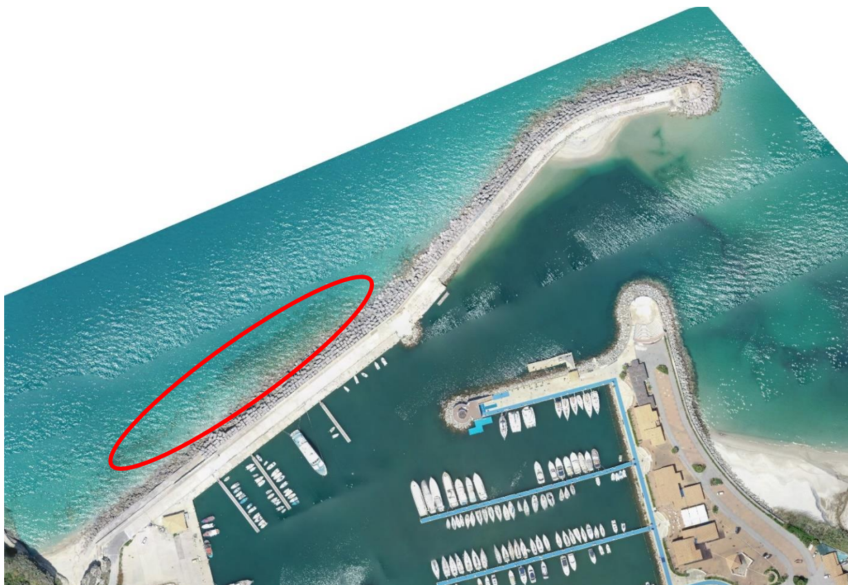
Figura 24: Vista dal drone dell’area di interesse - immagine del marzo 2020
