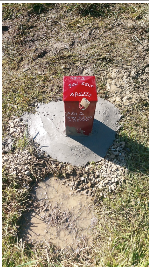
Pozzetto di protezione sondaggio A S02
