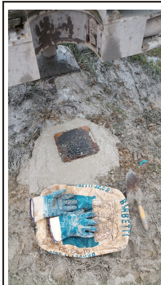
Pozzetto di protezione sondaggio A S08
