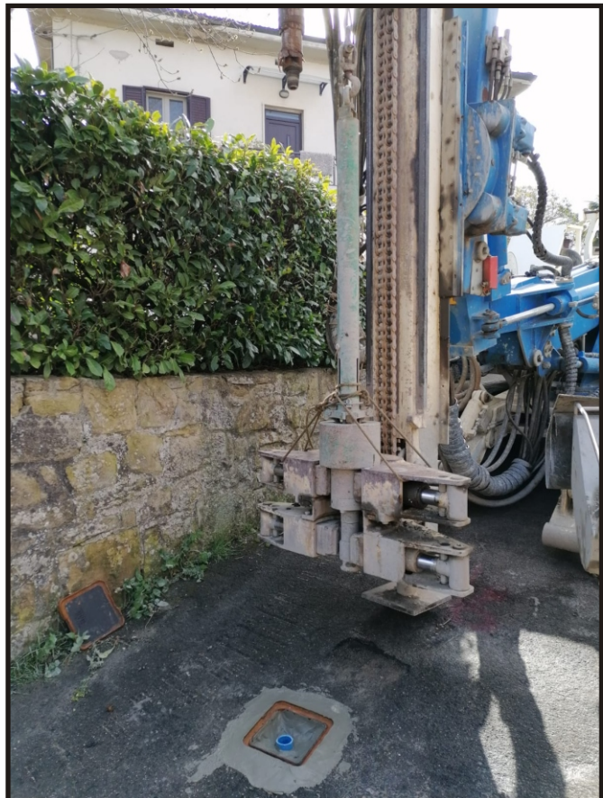
Allestimento tubo piezometrico e pozzetto di protezione Sondaggio A S06
