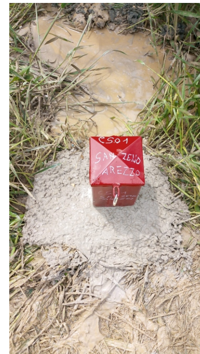
Pozzetto di protezione in ferro Foro C S01
