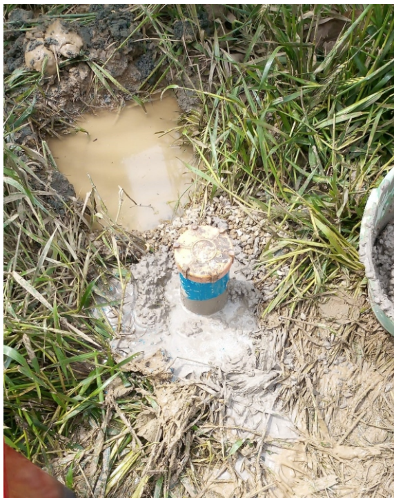
Tubo per prova geofisica di tipo Down-Hole
