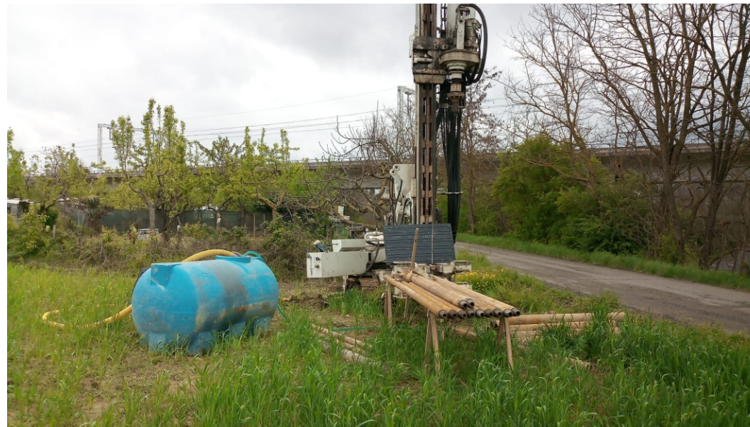
Postazione Sondaggio C S04
