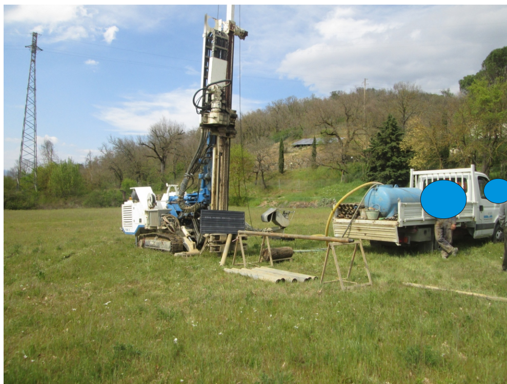
Postazione Sondaggio C S03
