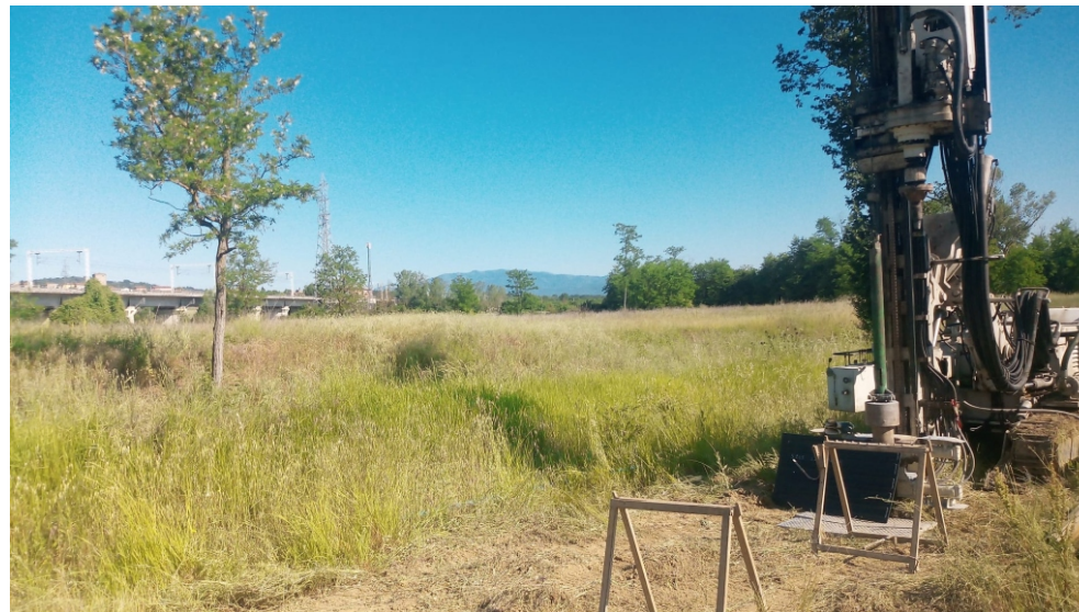
Postazione Sondaggio C S05
