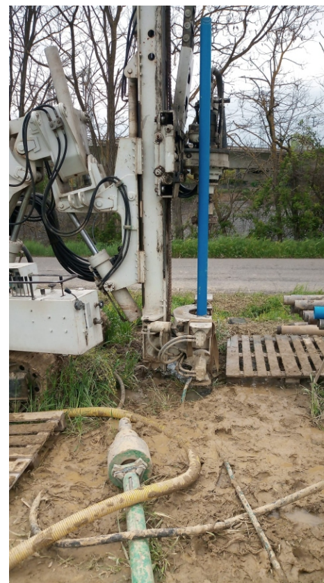
Installazione Tubo per prova geofisica di tipo Down-Hole
