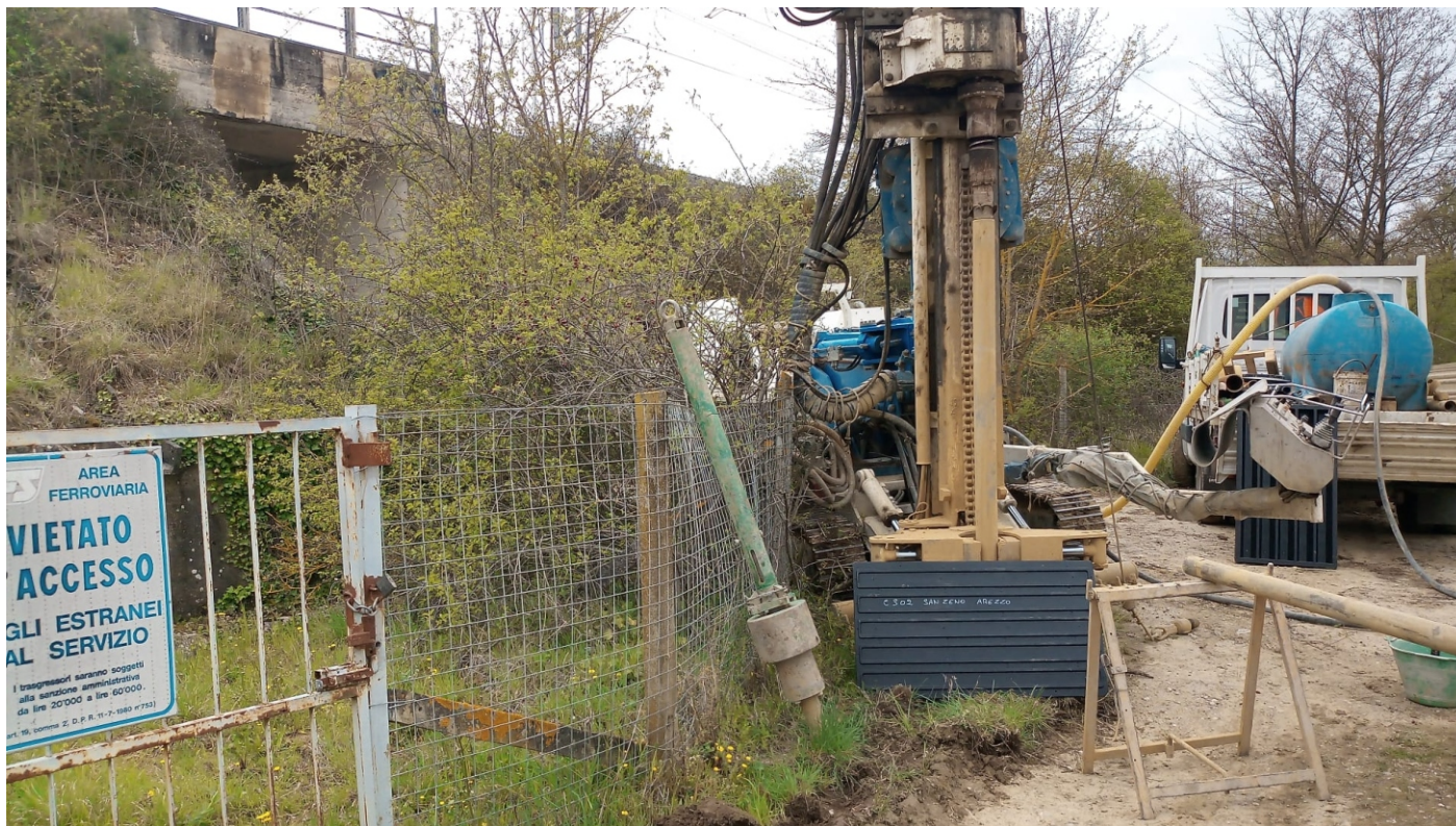
Postazione Sondaggio C S02
