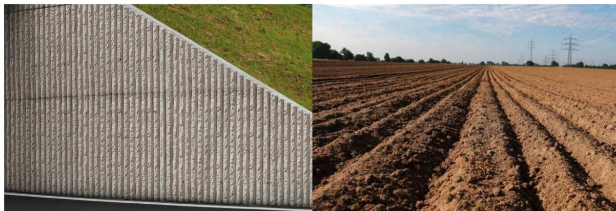
Figura 9.31 Muri in cemento facciavista trattati con matrici a motivo rigato a spacco irregolare.
