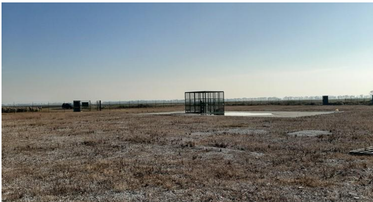
Figura 3.7: Immagine esempio testa pozzo in gabbia di protezione (non oggetto del presente studio)
