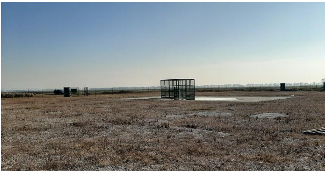
Figura 5.9: Immagine esempio testa pozzo in gabbia di protezione (non oggetto del presente studio)
