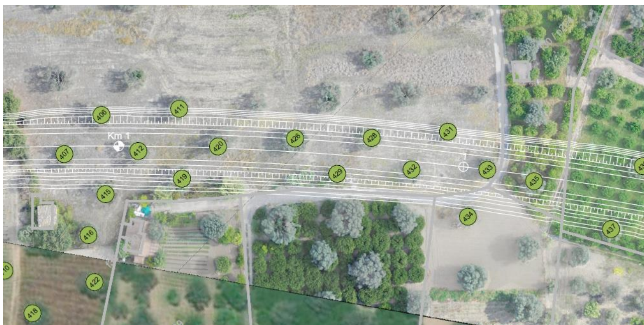
Figura 91 - Olivi interferiti presso il cantiere lineare
