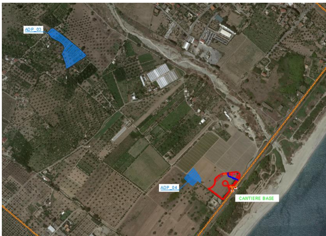
Figura 77 - Siti provvisori di stoccaggio e cantiere base
