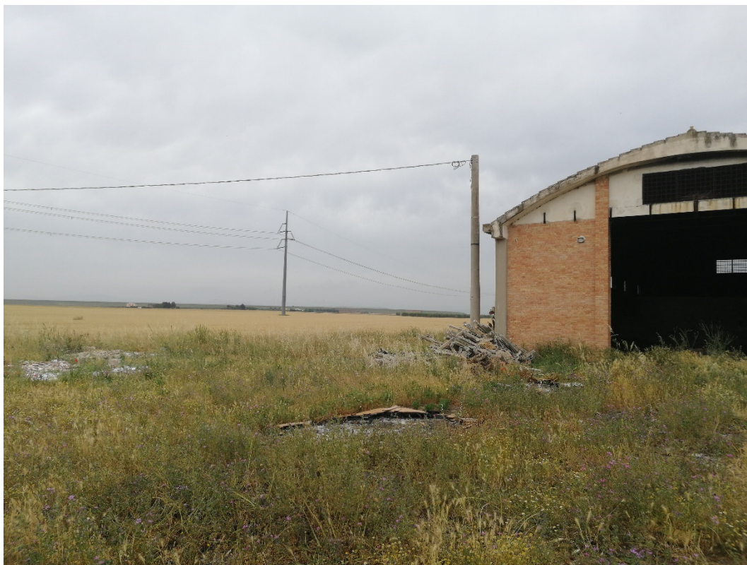
Foto 12 (Linea BT verso il deposito e linea AT)
