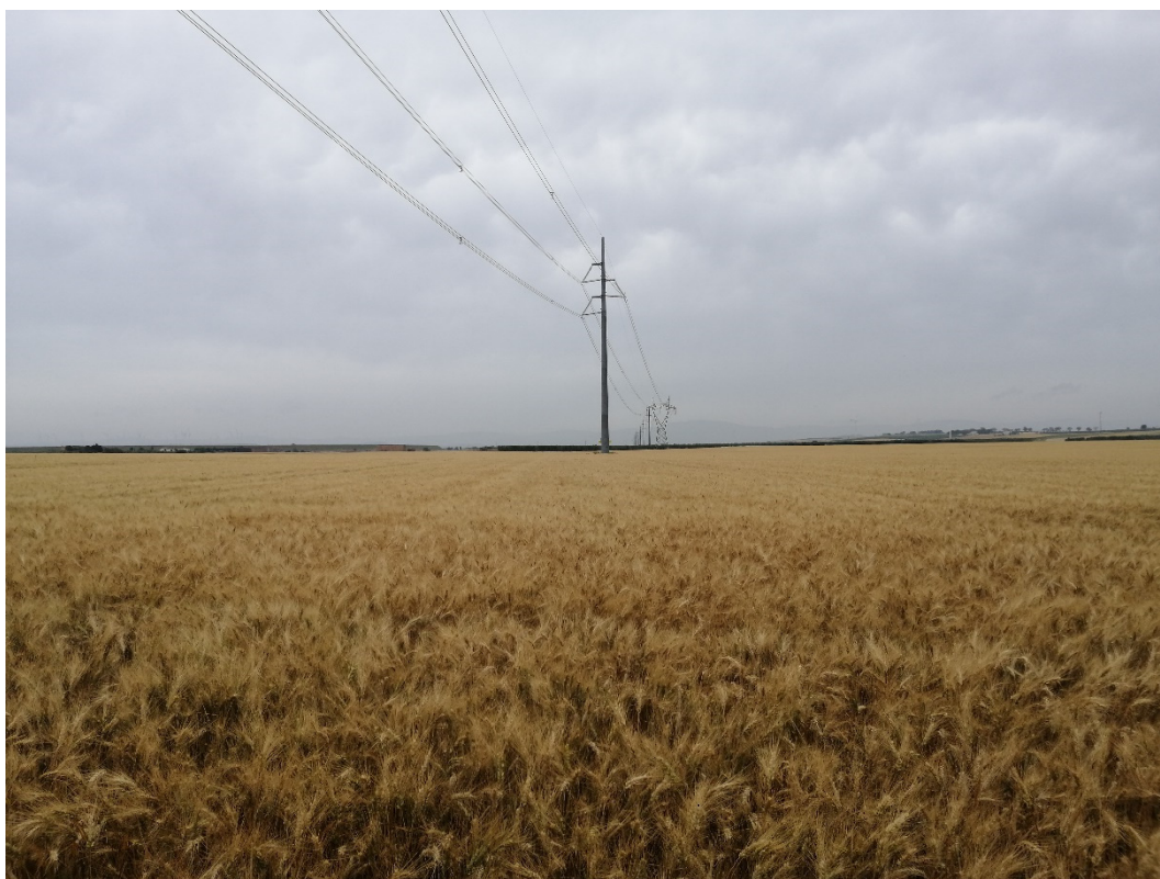
Foto 14 (linea AT verso ovest)
