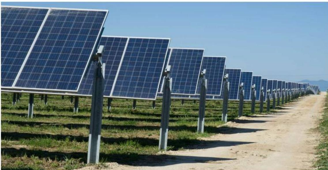
**Figura 2:** Struttura mobile ad inseguitore solare portamoduli TRACKER
