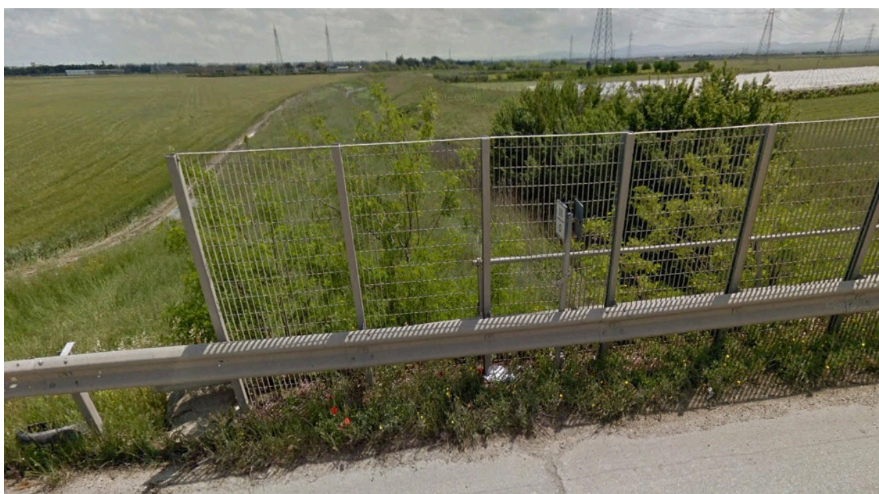
Il Torrente Celone, scavalcato dalla SS 673, nel punto in cui sarà attraversato dal cavidotto
